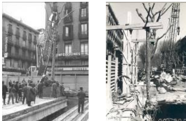
Afectació d'arbres a les obres del metro Liceu. Abril de 1968 Font: Arxiu de Parcs i Jardins
