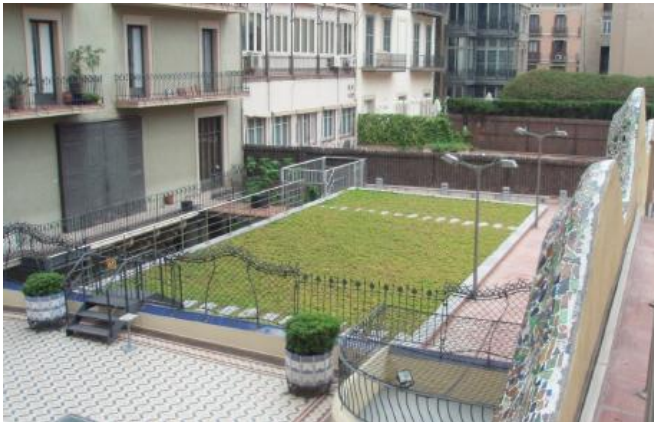
Coberta verda a Servicio Estación. Barcelona
